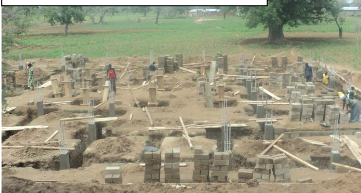
Erste Bauarbeiten an der Berufsschule, Juli 2012
